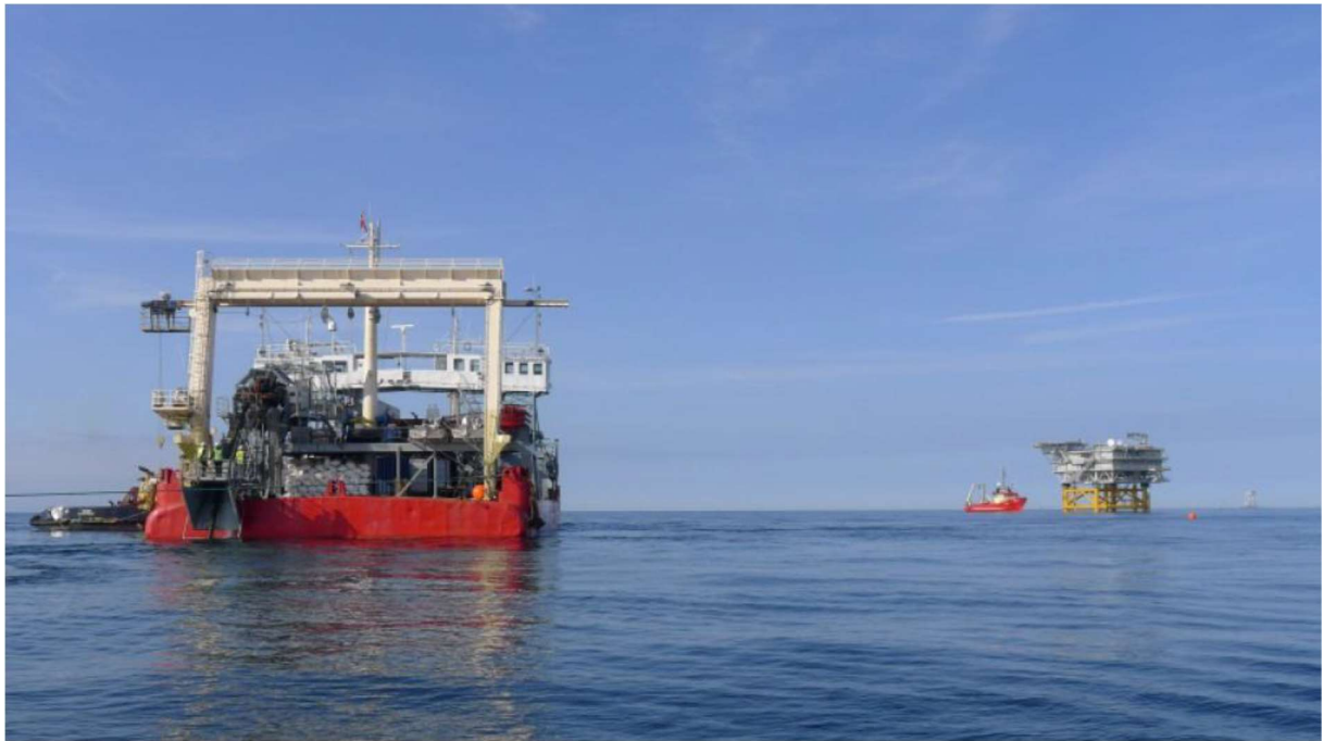
Slika 7.2: Teglenica za polaganje kabela (CBL) [1]
