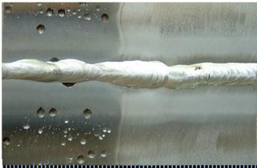
Slika 3.5 Rupičasta korozija čelika [8]
