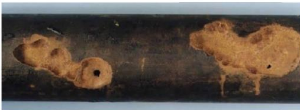
Slika 3.22 Oštećenje uslijed korozije djelovanjem lutajućih struja [8]
