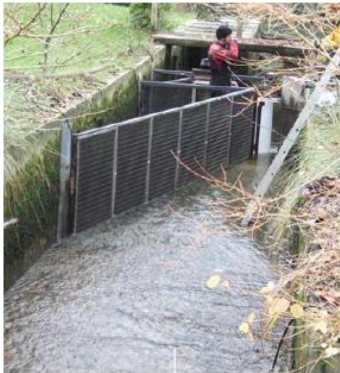
Slika 4.1. Izrada eksperimentalne rešetke [9]
