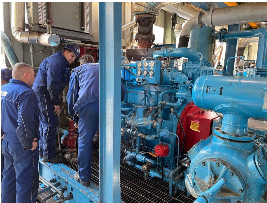
Slika 6.9 Završni radovi generalnog remonta - puštanje u rad [autor]
