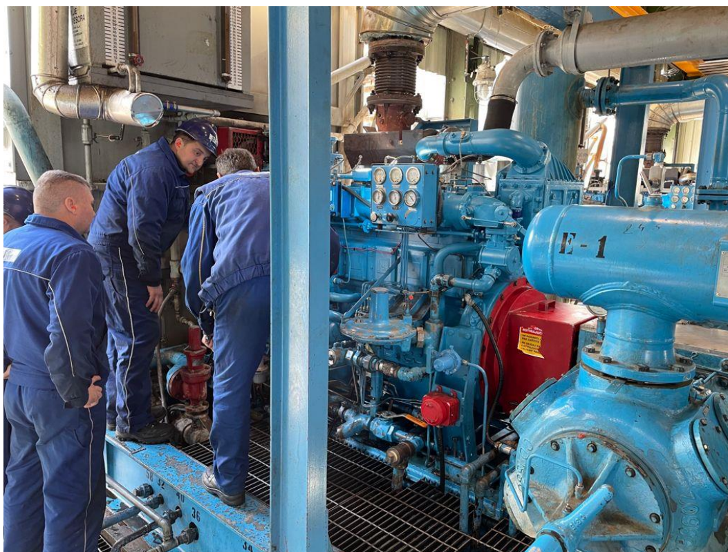
Slika 6.9 Završni radovi generalnog remonta - puštanje u rad [autor]
