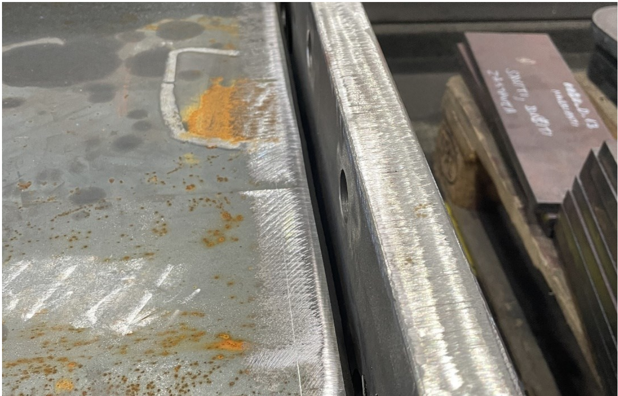
Slika 9.2. Priprema površine i oblikovanje elemenata za zavarivanje
