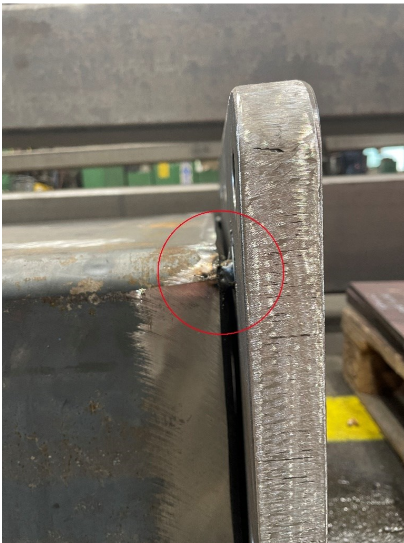
Slika 9.3. Pripojno zavarivanje spojnih elemenata
