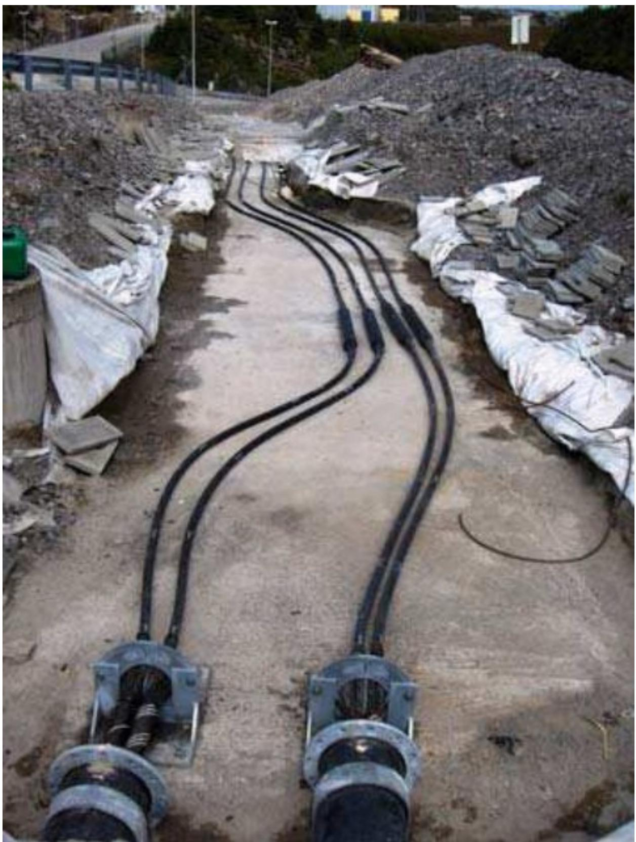
Slika 4.21. Prikaz spojeva na kopnu za dva para ekstrudiranih HVDC kabela [13]
