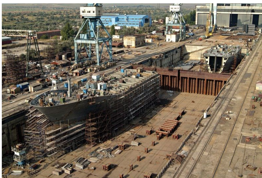
Slika 6.3. Montaža na suhom doku
