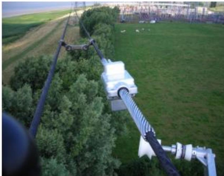
*Slika 5.16. Senzor Ampacimon postavljen na 400 kV vod [42]*
