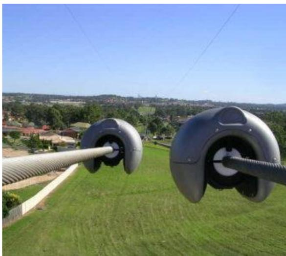
*Slika 6.3. OTLM uređaji montirani na dalekovodu [46]*
