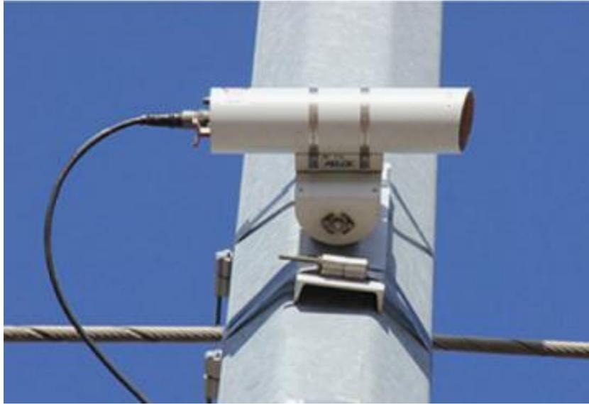
*Slika 5.15. Video kamera iz sustava Span Sentry (EDM)*
