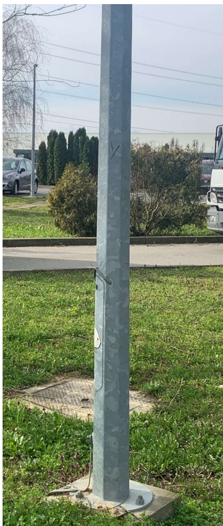
Slika 6.20: Prevlaka cinka na metalu
