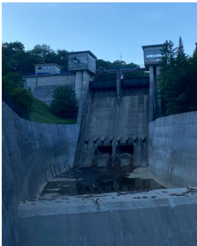
Slika 2.3. Brana hidroelektrane Rijeka
