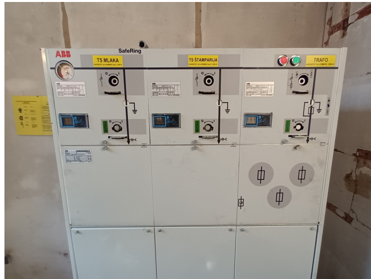
Slika 2.4. ABB SN sklopni blok [4]
