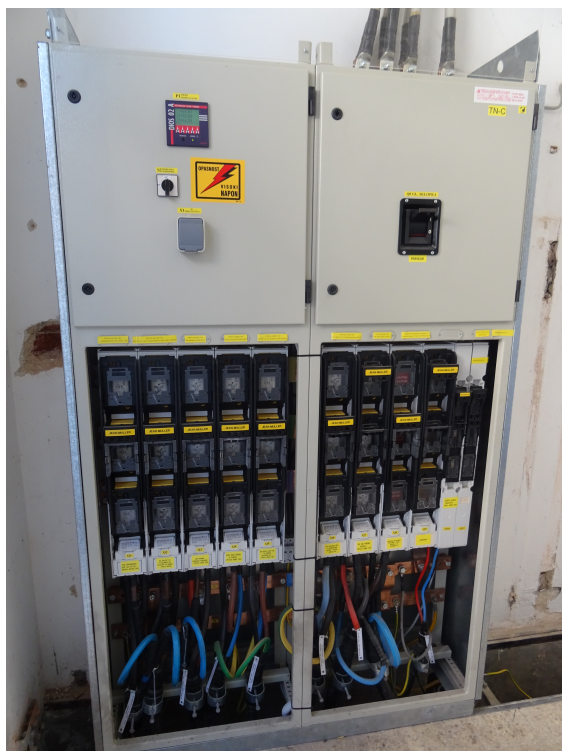
Slika 2.5. NN sklopni blok [4]
