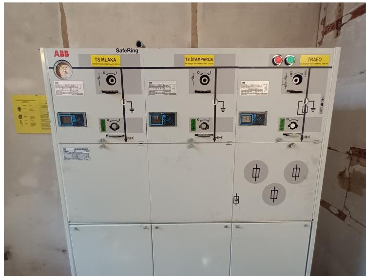
Slika 2.4. ABB SN sklopni blok [4]
