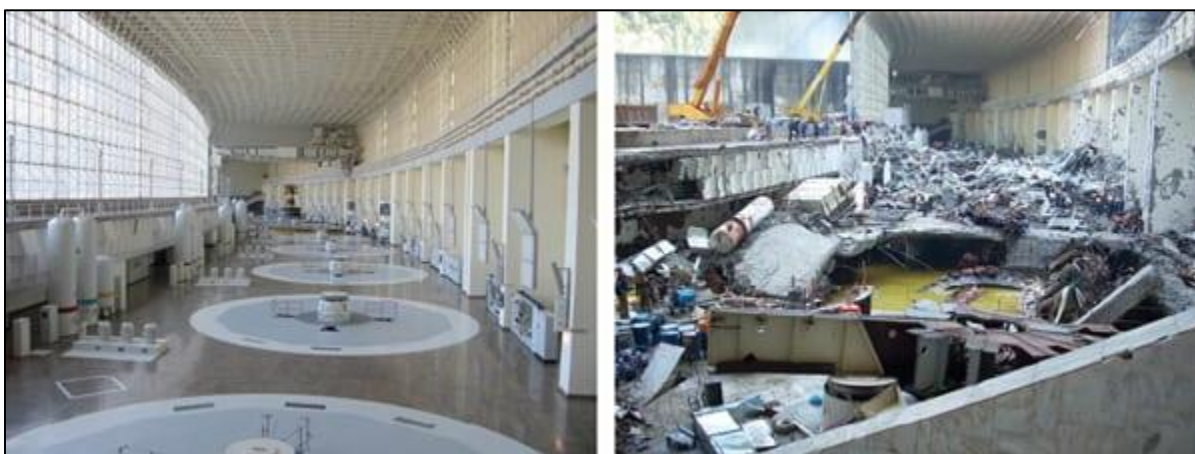
Slika 2.3 Postrojenje prije i poslije katastrofe [9]
