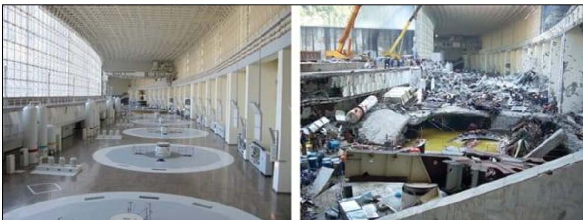
Slika 2.3 Postrojenje prije i poslije katastrofe [9]
