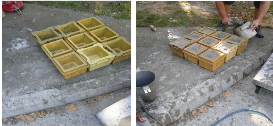
Slika 29 Prazni pripremljeni kalupi i napunjeni svježim betonom
