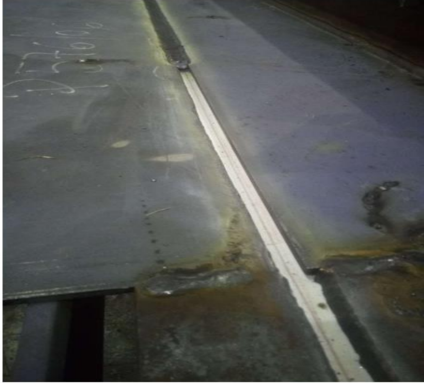
Slika 8.4. 2: Priprema za sučeljni spoj
