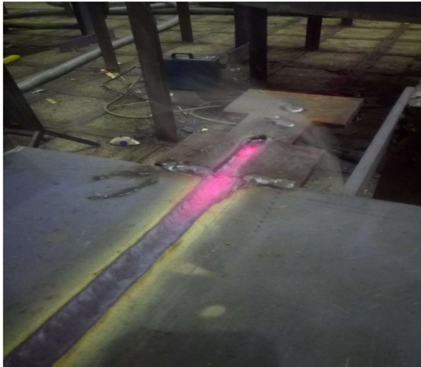
Slika 8.4. 3: Izveden sučeljni spoj
