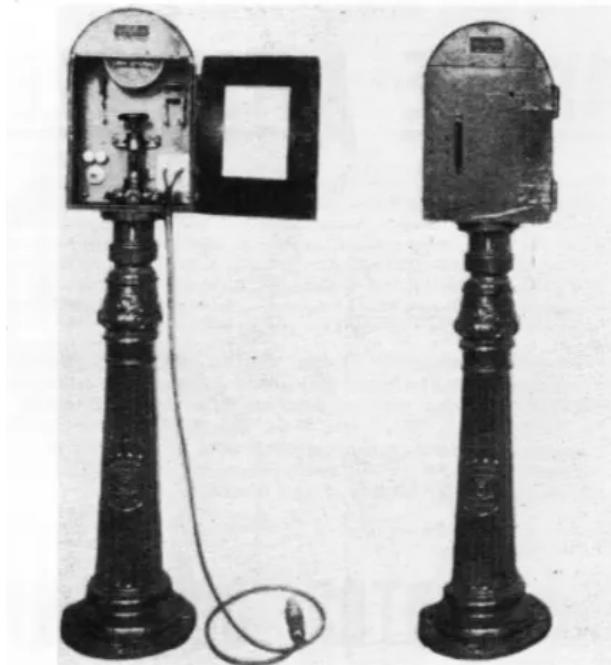
Slika 2.3 Prve punionice za električna vozila("Electrant")[7]
