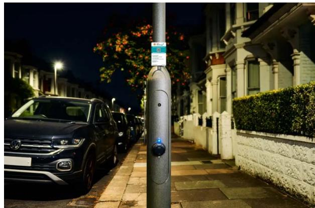
Slika 6.1 Stup s ugrađenim priključkom za punjenje vozila
