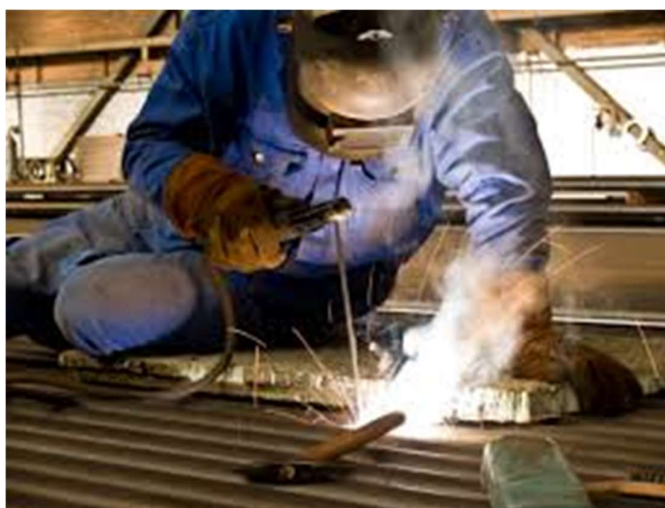
Slika 4 REL zavarivanje [5]
