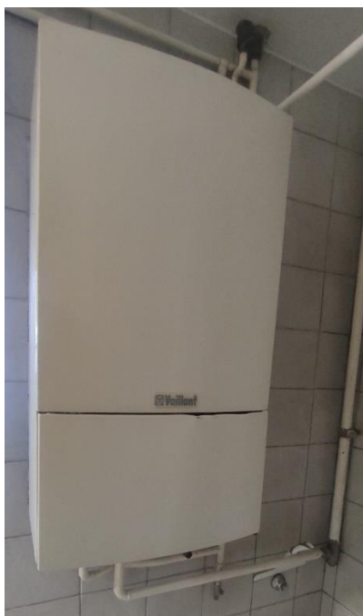
Slika 5.2. Plinski bojler Vaillant tip THERMOcompact VU 182/1
