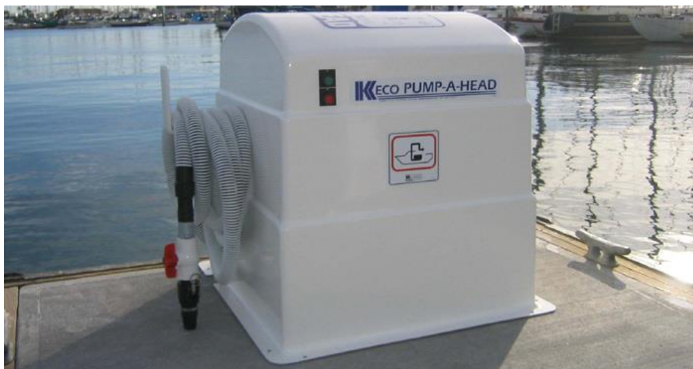
Slika 3022 - Pump-out sustav u marini[32]
