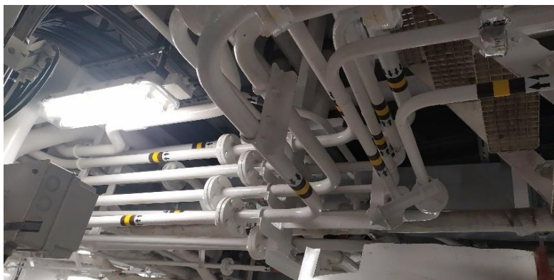
Slika 4.8. Primjer obilježenog cjevovoda na brodu
