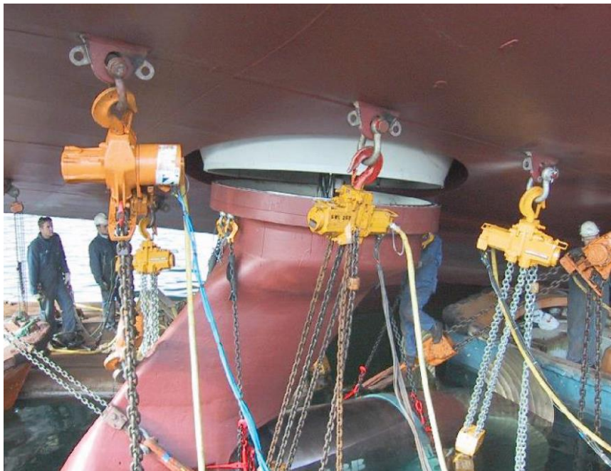
Slika 56. Primjer podizanja i montaže modula sa parancima, uškama i škopcima
