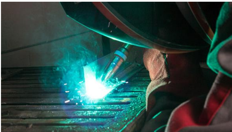
Slika 13. Zavarivanje MIG/MAG postupkom
