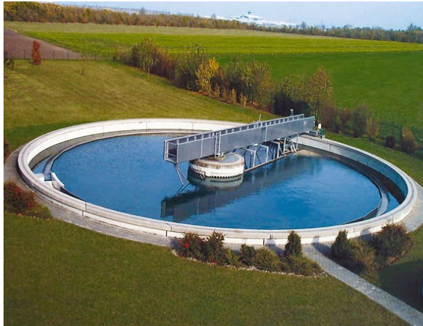
Slika 3.3. Sekundarni taložnik [4]
