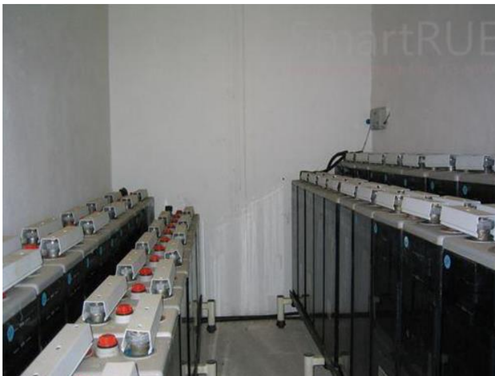
Slika 6.6. Baterijski sustav 48 kWh [17]
