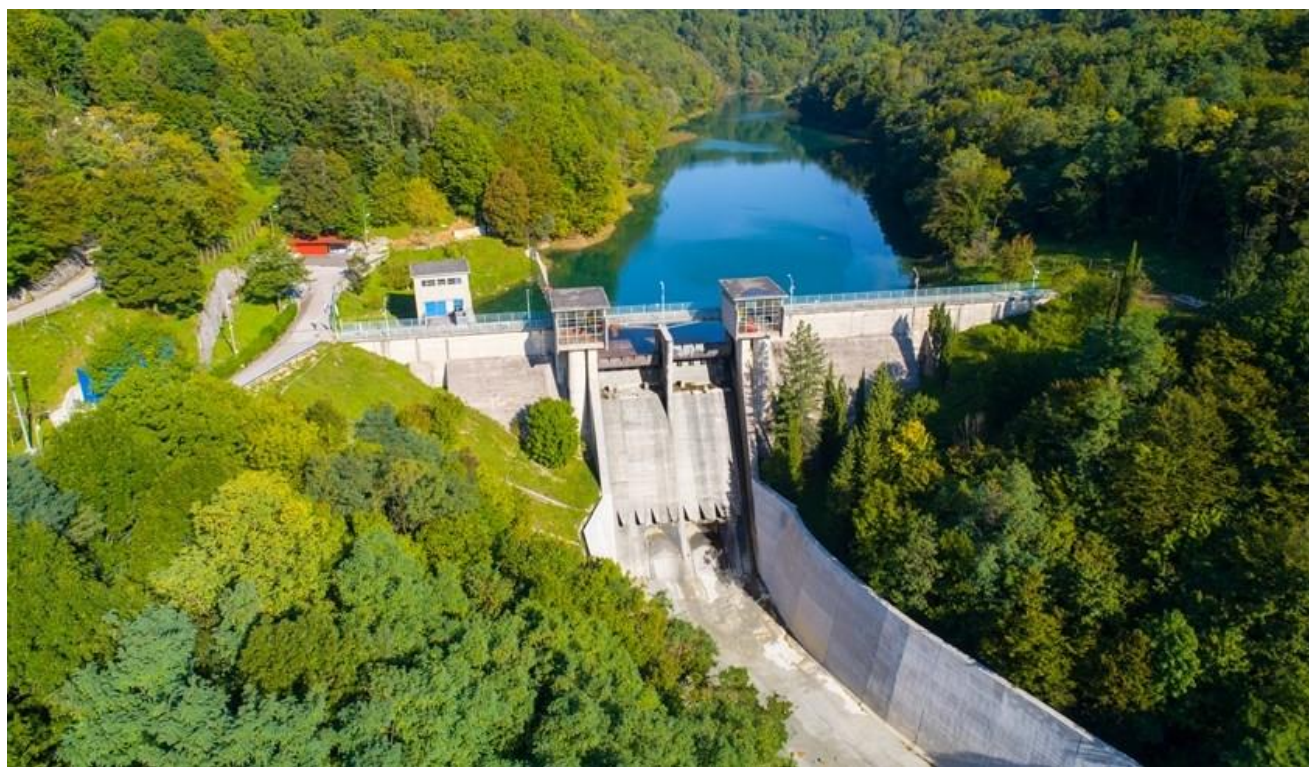
Slika 3.1. Akumulacija i brana HE Rijeka (Izvor: hep.hr)
