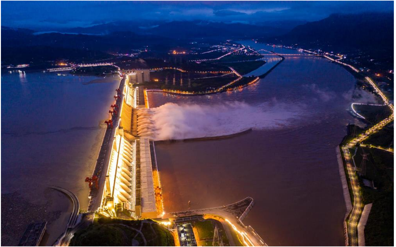
Slika 2.7. Velika hidroelektrana Tri klanca (Izvor: Jutarnji.hr)
