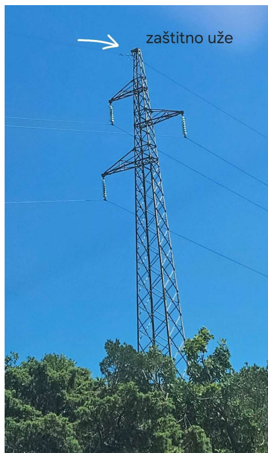
Slika 2.8. VN metalni dalekovod sa zaštitnim užetom
