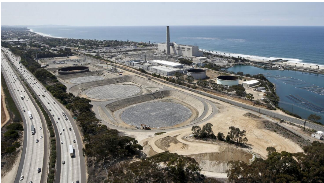
Slika 4.5. Desalinizacijsko postrojenje „Carlsbad“, SAD, Kalifornija [38]
