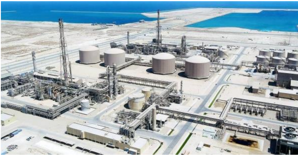
Slika 4.2 Desalinizacijsko postrojenje „Ras Al Khair“, Saudijska Arabija [35]
