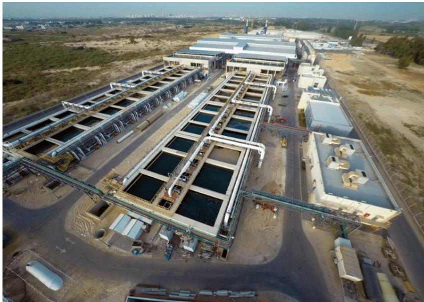
Slika 4.3. Desalinizacijsko postrojenje „Sorek“, Izrael [36]
