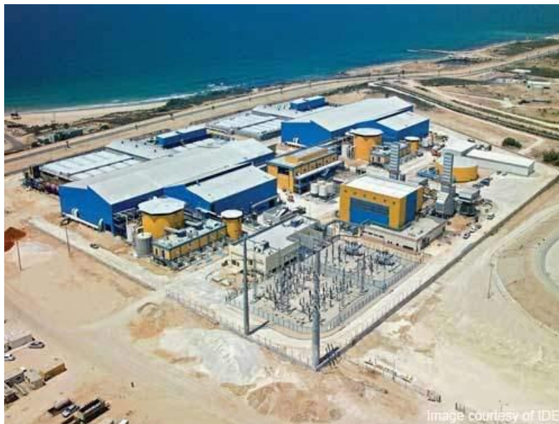
Slika 4.4. Desalinizacijsko postrojenje „Ashkelon“, Izrael [37]
