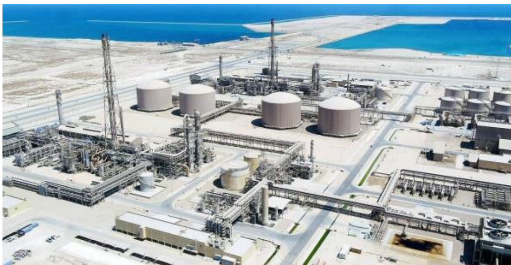
Slika 4.2 Desalinizacijsko postrojenje „Ras Al Khair“, Saudijska Arabija [35]
