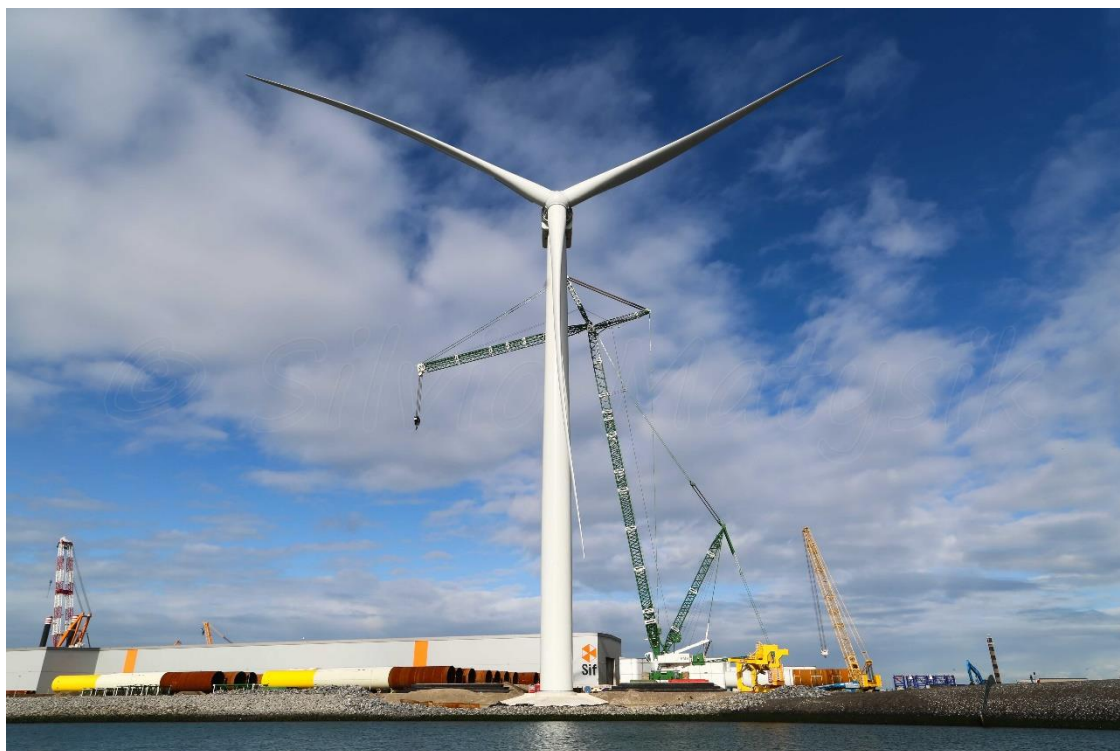
Slika 3.4. Priobalna vjetroturbina Haliade-X u Rotterdamu [12]
