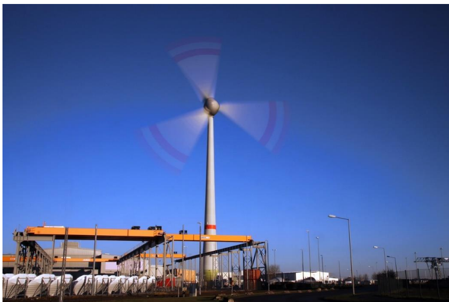
Slika 3.6. Kopnena vjetroturbina E-126 u Magdeburgu [15]
