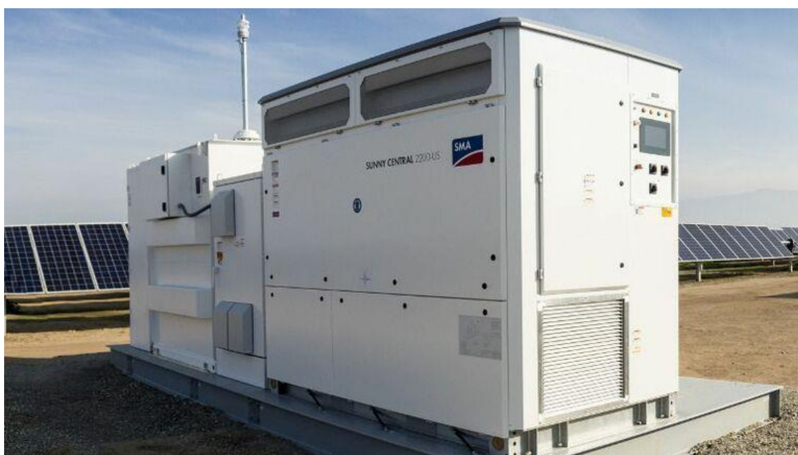
Slika 4.5.: Izmjenjivač SMA Sunny Central 2200
