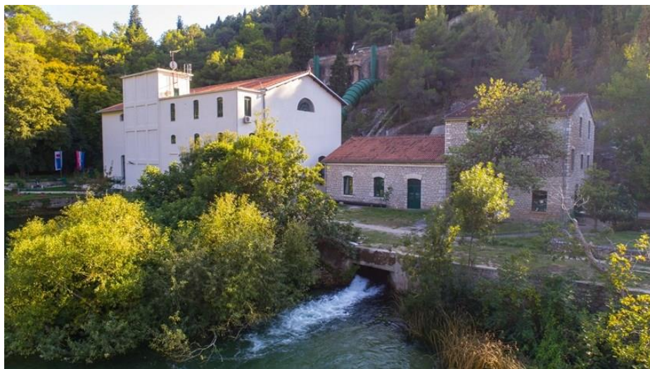
Slika 3.5 Hidroelektrana Jaruga, rijeka Krka [11]
