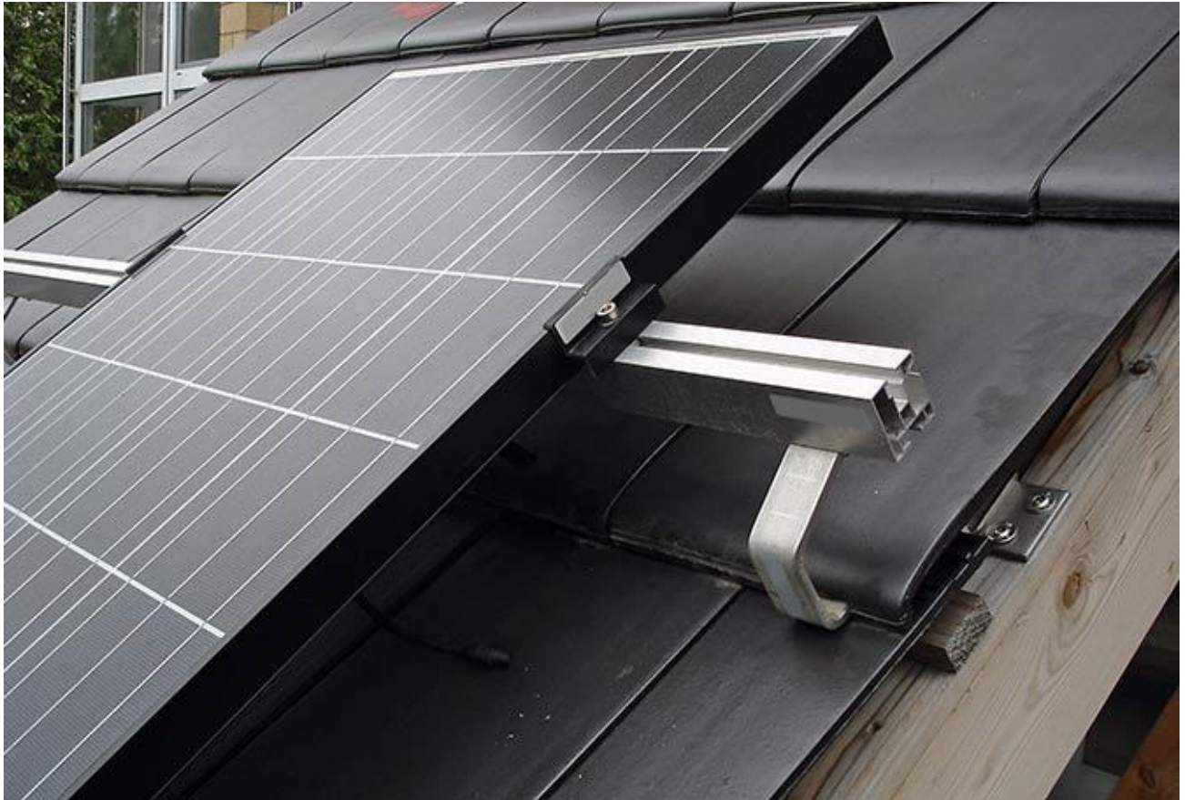
Slika 9.1 Ugradnja solarnog panela
