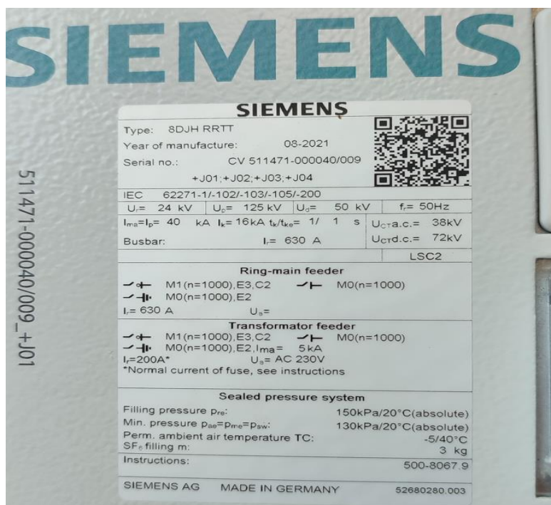
Slika 3.7. Natpisna pločica sa specifikacijama novog SN bloka
