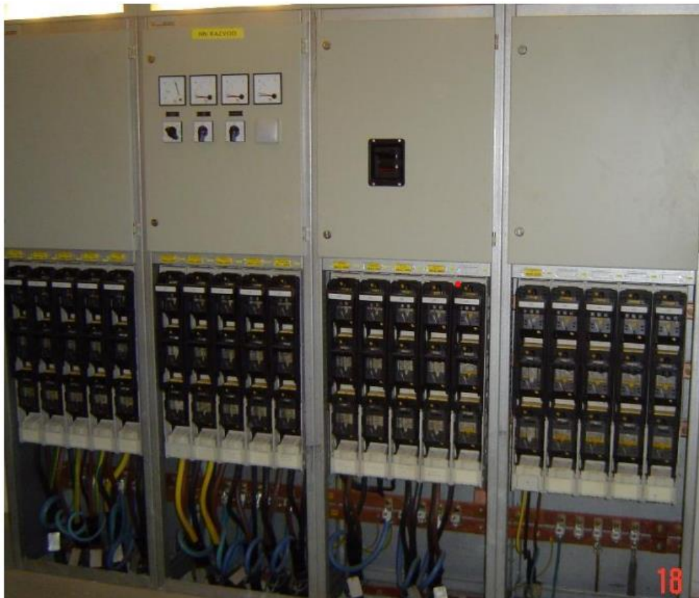
Slika 3.9. Prikaz novijeg NN sklopnog bloka – kompaktni oblik [3]
