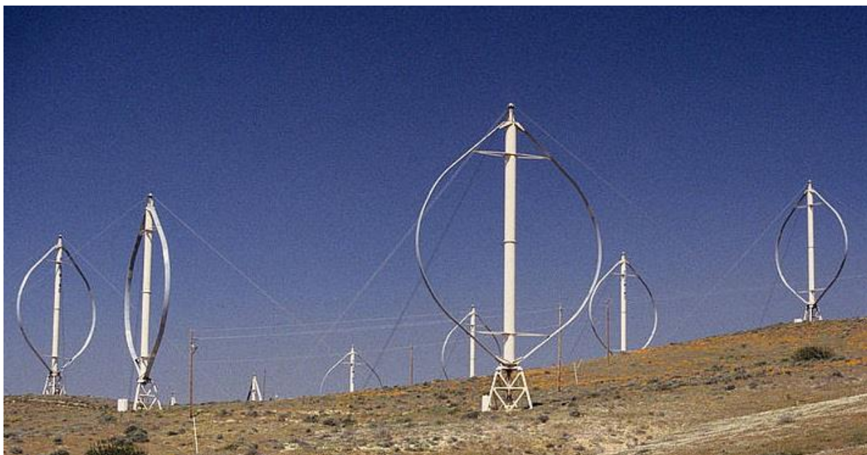
Slika 2.8. Darrieus "eggbeater" vjetroelektrana u prijevojima Altamont i Tehachapi u Kaliforniji [11]
