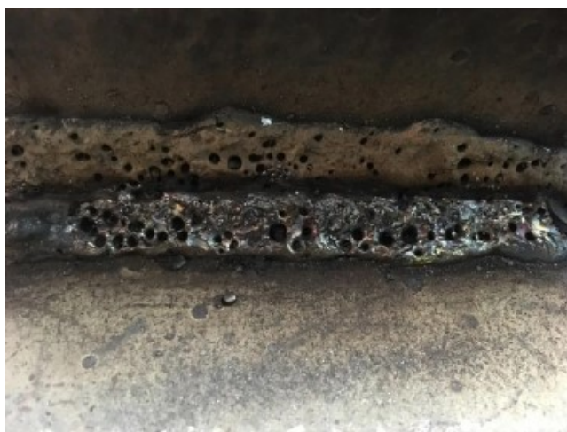
Slika 8.2. Poroznost u zavarenom spoju [43]
