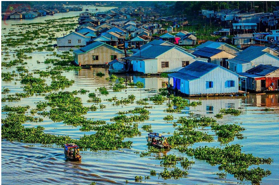
Slika 2.1. Plutajuće kuće na rijeci Chau Doc [1]
