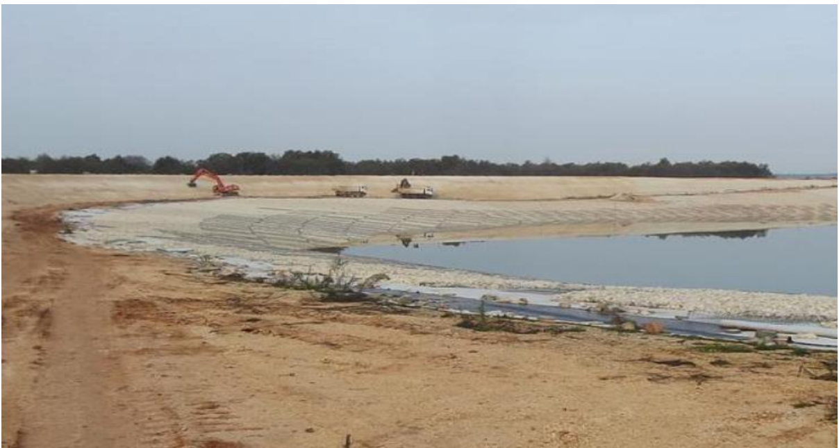
Slika 2.2. Akumulacijsko jezero Bakranjuša prilikom izgradnje
