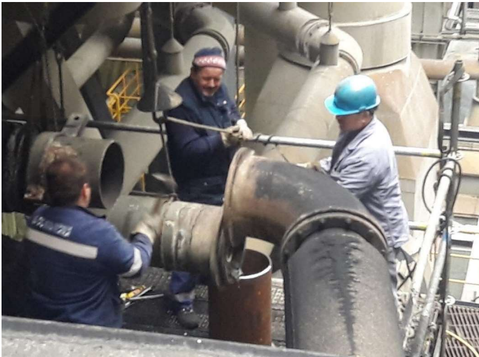
Slika 3.12. Provedba korektivnog održavanja na podsustavu cjevovoda ugljene prašine
