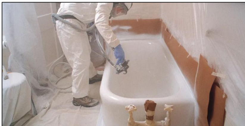
Slika 6.21. Restauracija kade od lijevanog željeza emajliranjem [85]
