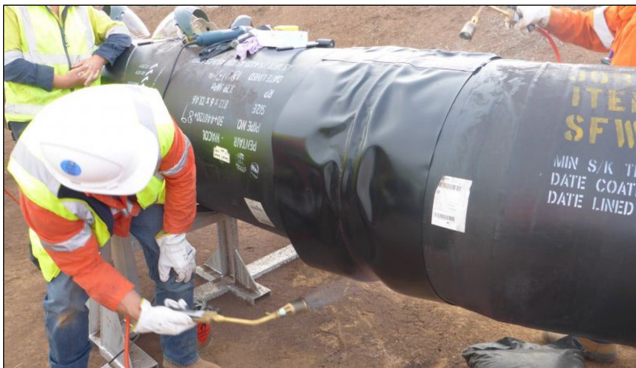
Slika 6.24. Bitumenizacija zavarenog spoja plinovoda [90]
