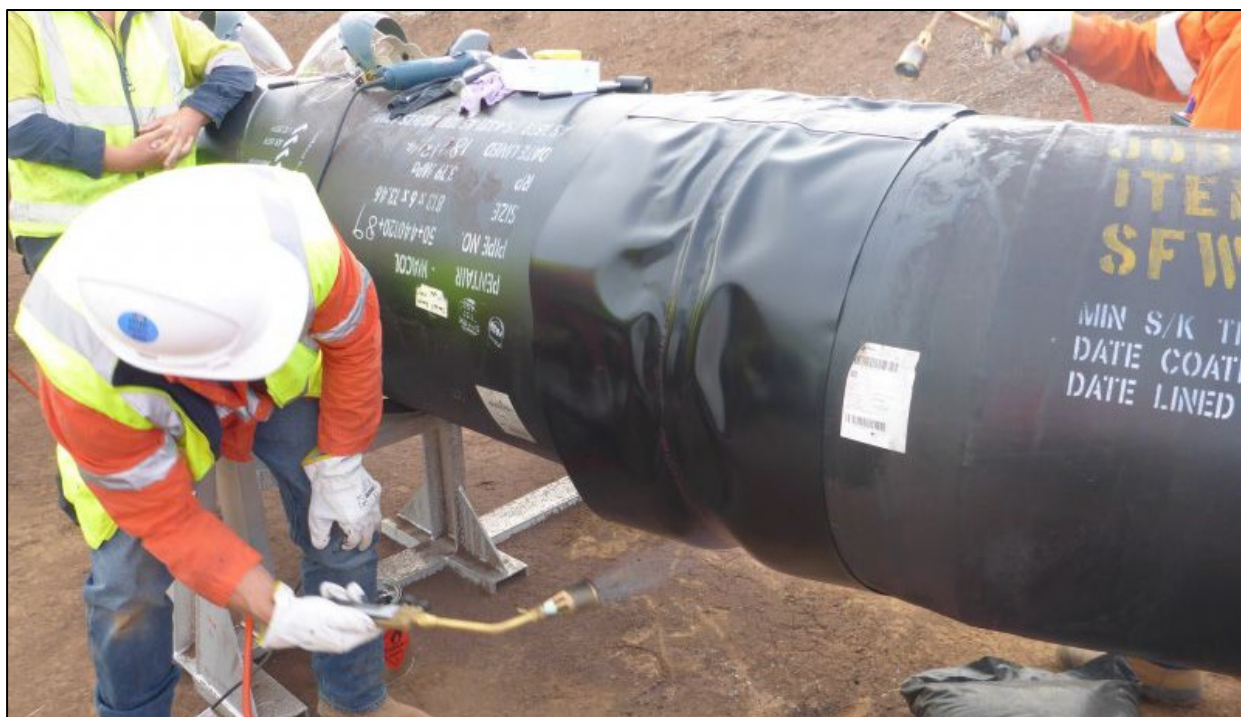
Slika 6.24. Bitumenizacija zavarenog spoja plinovoda [90]
