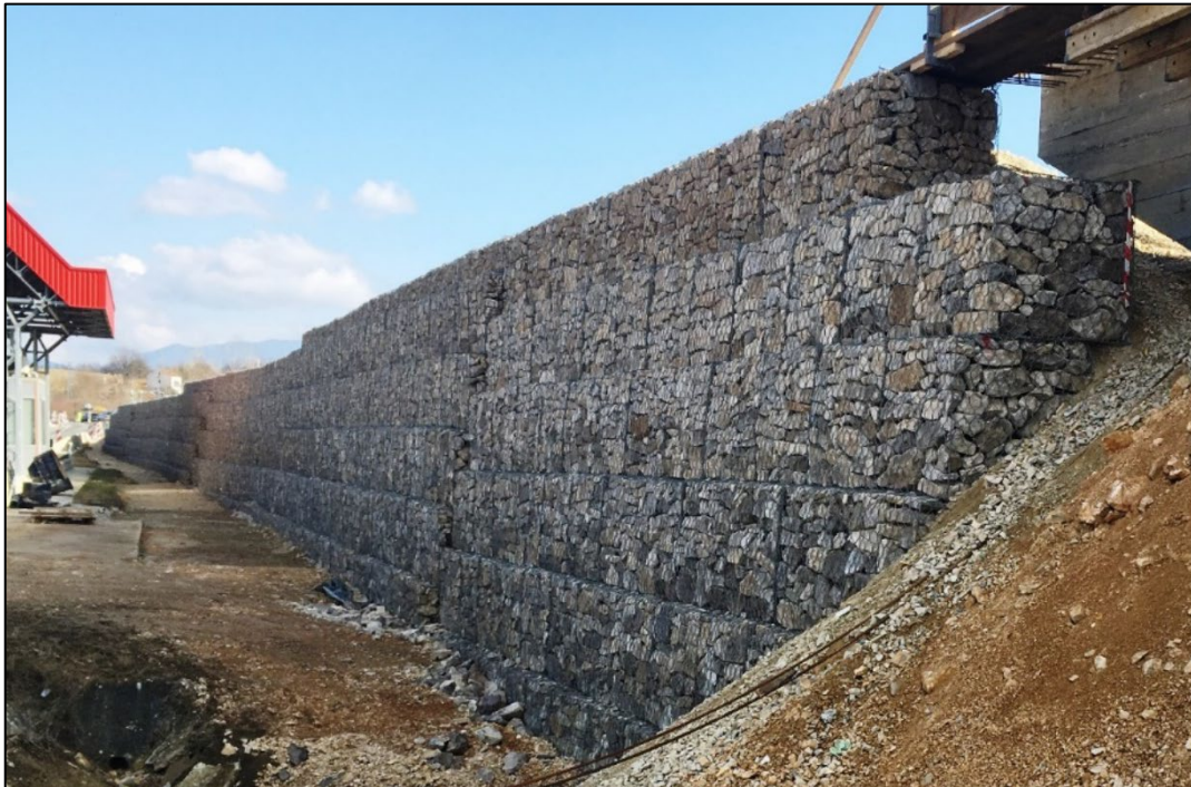
Slika 7.2. Potporni zid od gabiona s pletenom čeličnom mrežom – Istarski ipsilon – Ivoli [92]
