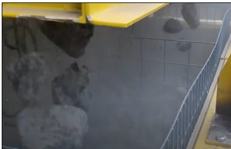
Slika 7.18. Punjenje i vibriranje kamena u gabion na vibratoru
