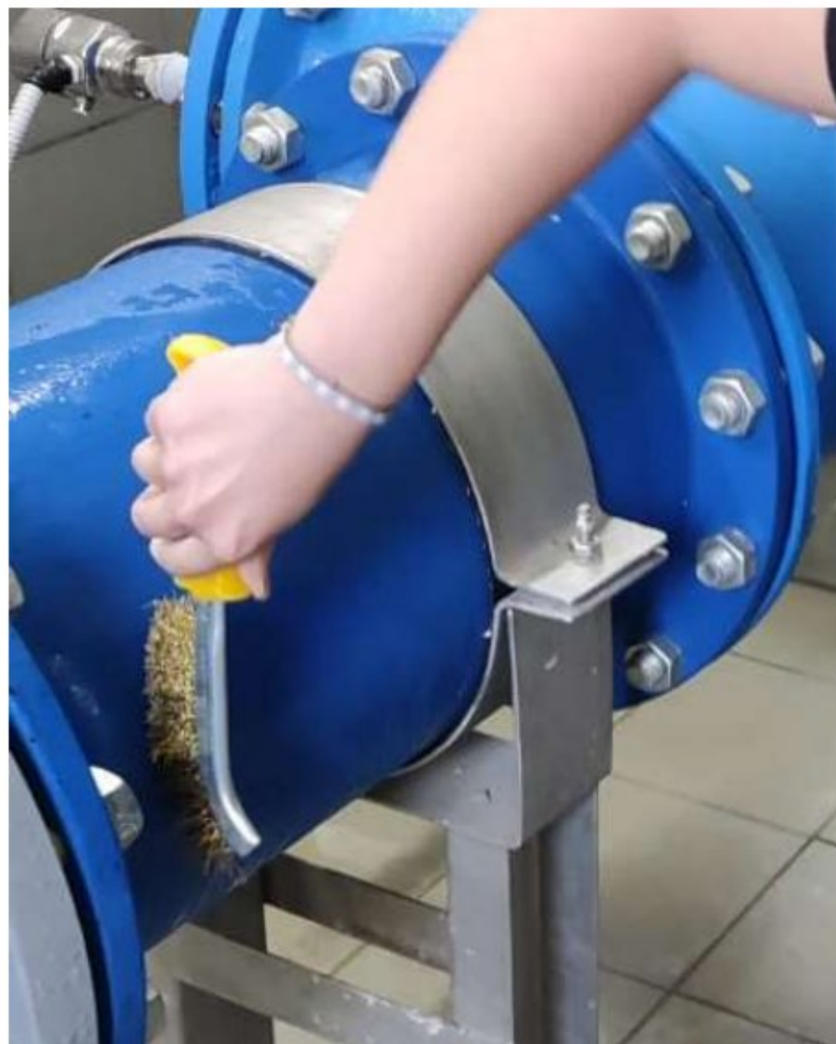
Slika 13: Ljuštenje boje sa cijevi
