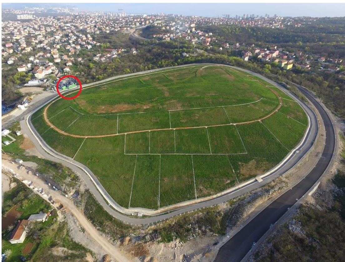
Slika 3.8 Bivše odlagalište otpada Viševac blizu Rijeke pretvoreno u digestor deponijskog plina [17]
