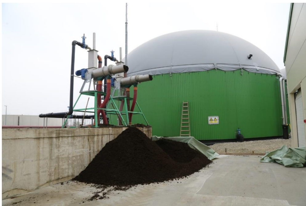
Slika 6.11 Vertikalni digestor s membranskim spremnikom bioplina [32]
