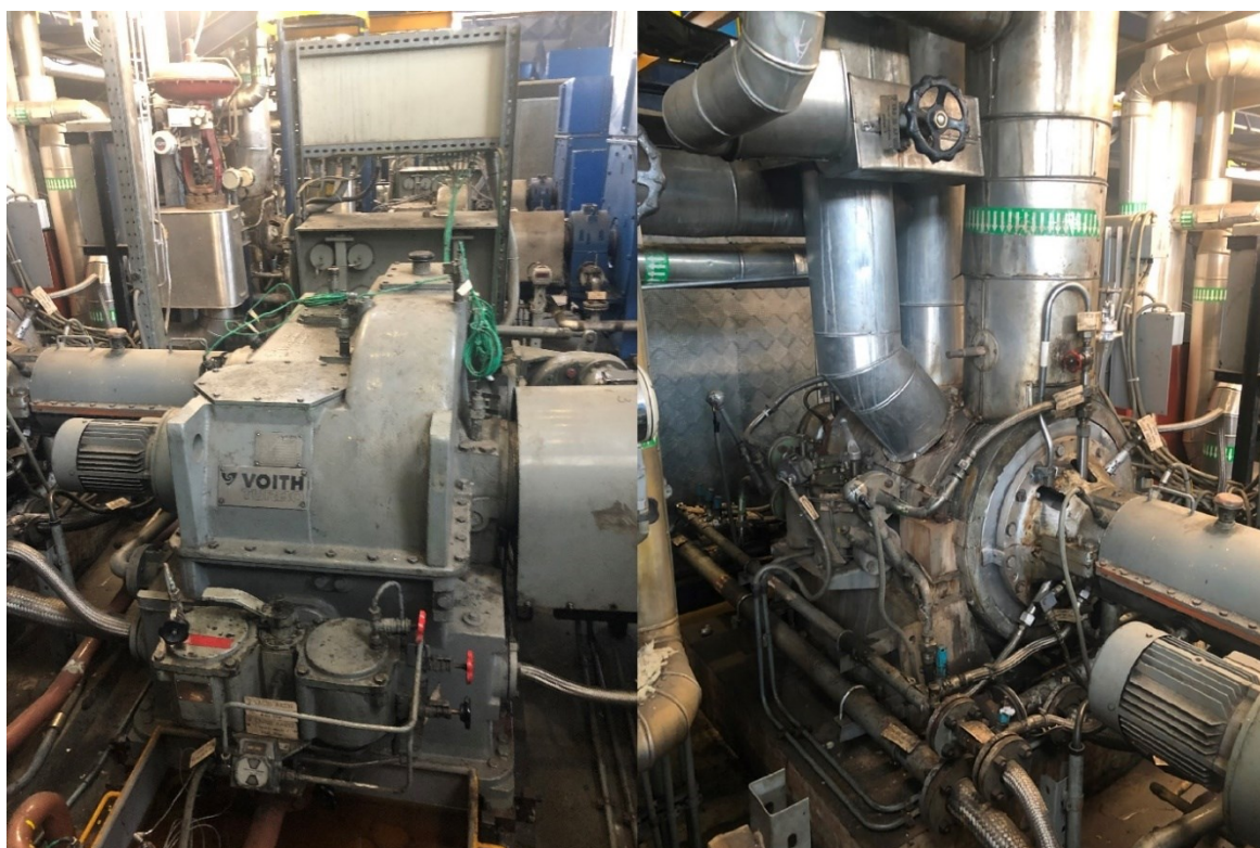
Slika 6.2. Hidraulička spojka i glavna napojna pumpa
