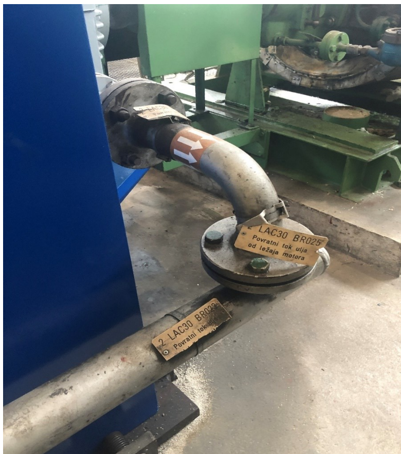
Slika 5.6. Prirubnica povratnog toka ulja kliznog ležaja
