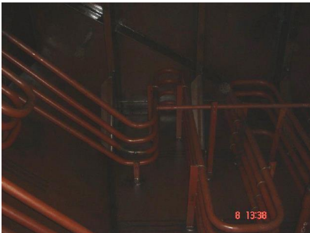
Slika 4.2 Unutrašnjost skladišnih tankova teškog goriva [1]
