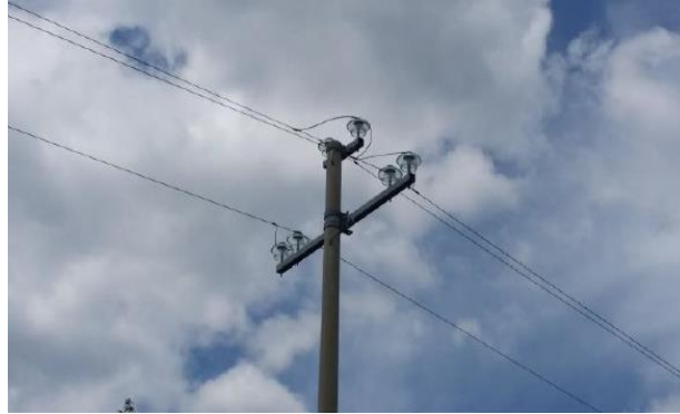
Slika 2.4. Potporni izolatori
