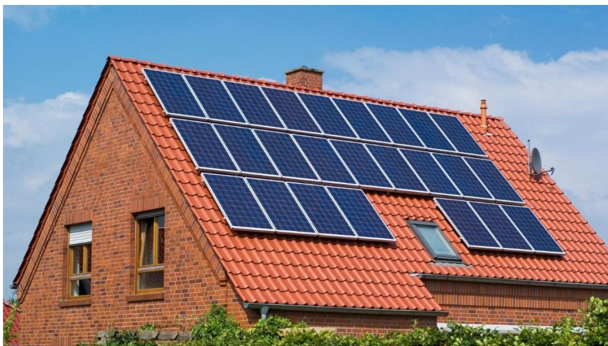
Slika 3.1. Krovni sustav solarnih panela
