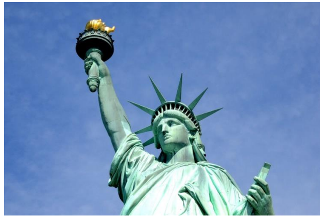
Slika 3.2. Ravnomjerna opća korozija na spomeniku Kip slobode [22]
