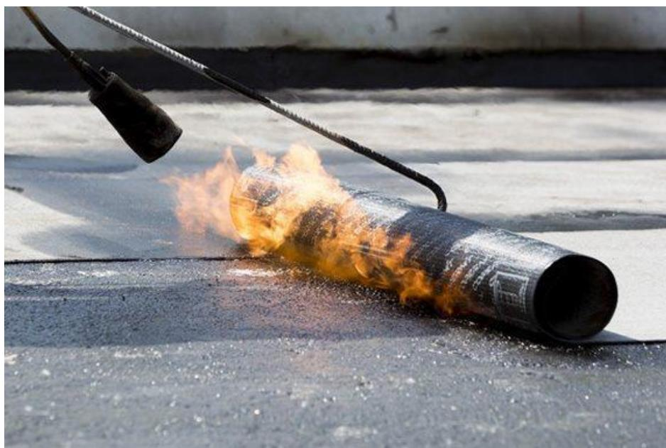
Slika 4.6. Bitumenizacija ravnog krova [47]
