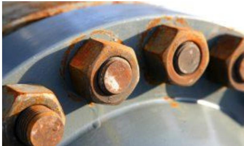
Slika 3.9. Galvanska korozija vijčanog spoja s prirubnicom
