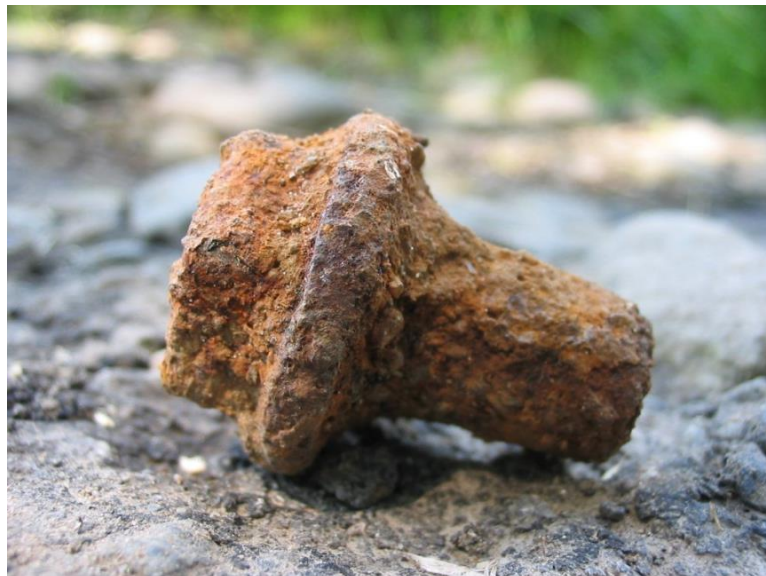
Slika 3.3. Neravnomjerna opća korozija vijka [23]
