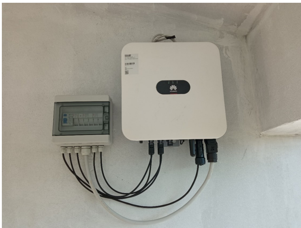
Slika 6.4 Prikaz montaže invertera Huawei SUN2000L-5KTL
