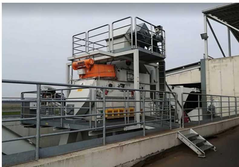
Slika 4.5. Primjer pužnog sustava do kotlovnice
