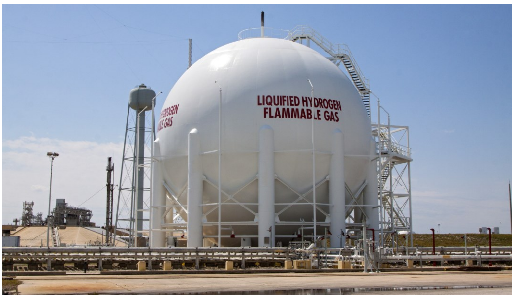
Slika 2.9. Spremnik tekućeg vodika na lokaciji svemirski centar Kennedy, SAD [16]
