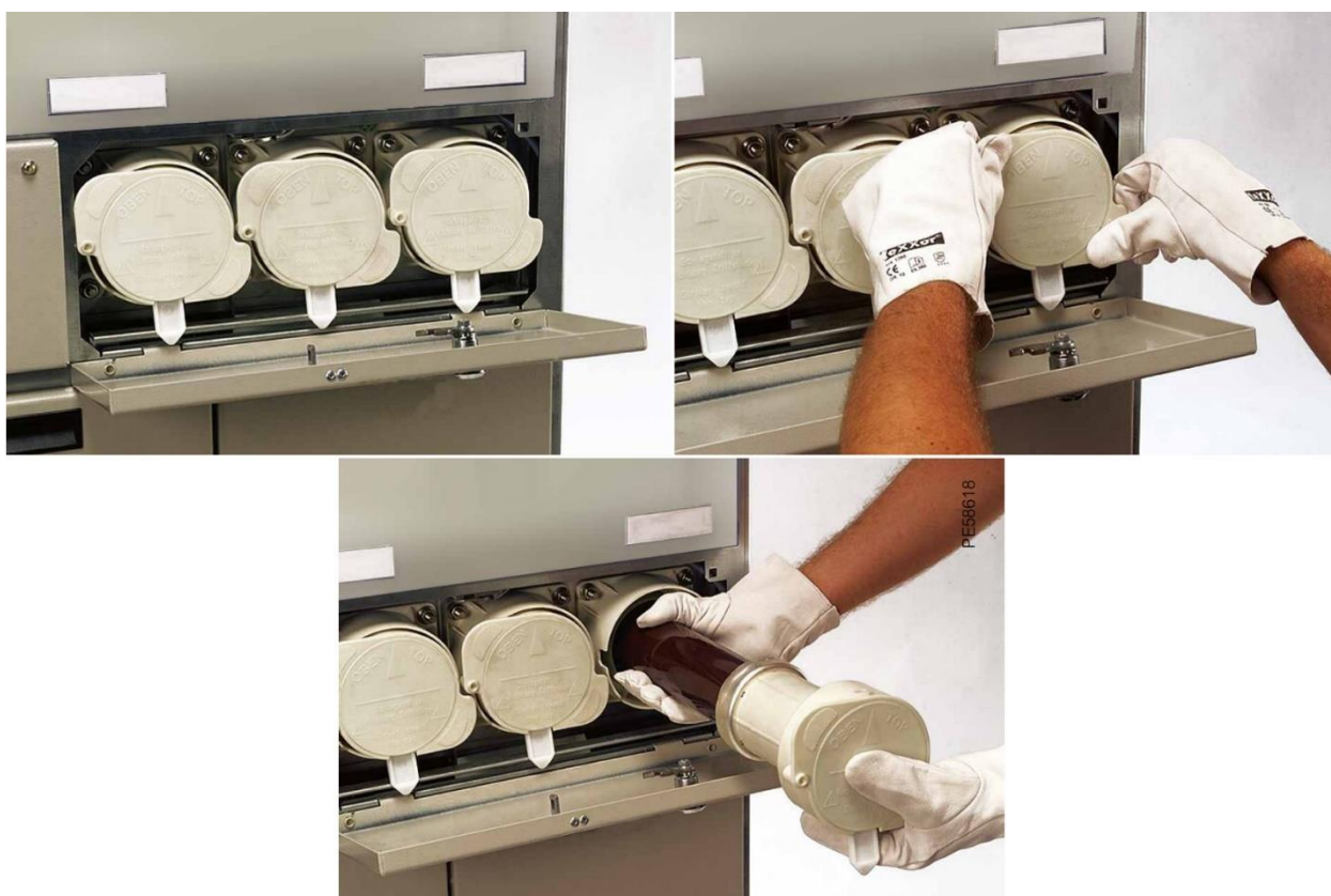
Slika 6.9. Prikaz zamjene osigurača u sklopnom bloku. Izvor: [11]
