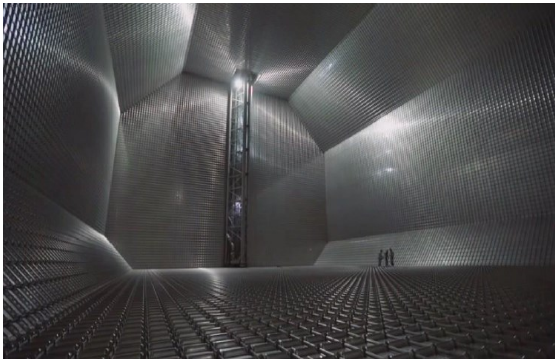
Slika 7.14. Prikaz unutrašnjosti spremnika izvedbe Technigaz (Mark III) [11]
