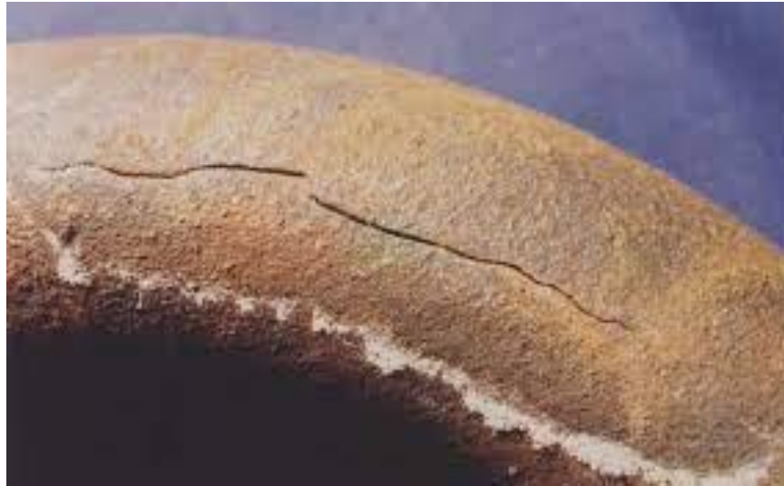
Slika 5.14. Napetosna korozija na savijenom dijelu cijevi [35]
