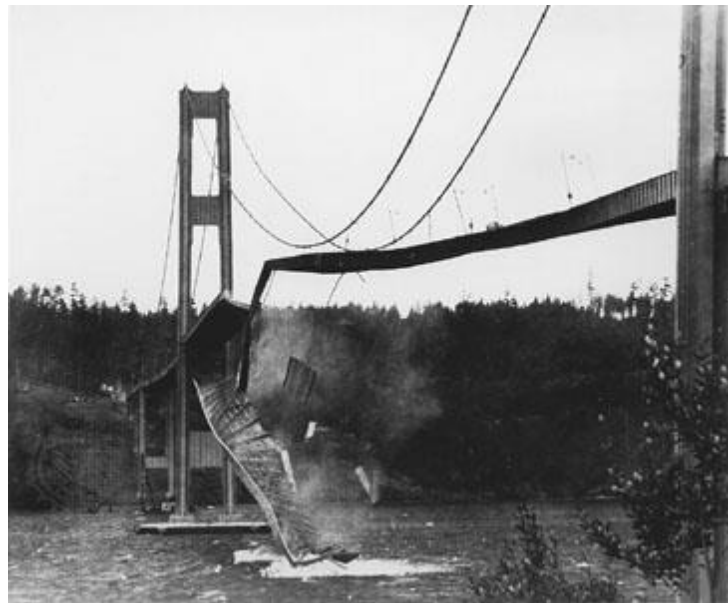
Slika 2.7 Urušavanje Tacoma Narrows Bridge-a [4]
