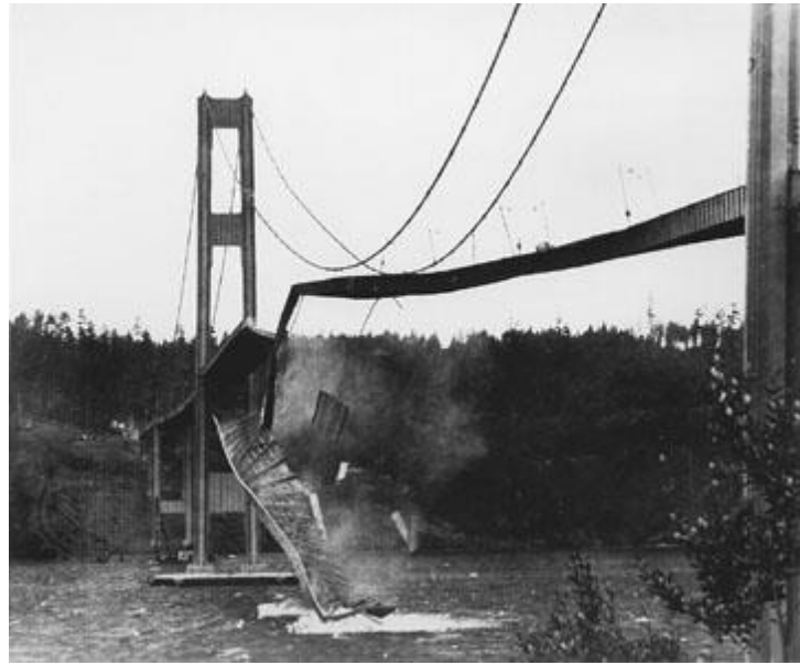
Slika 2.7 Urušavanje Tacoma Narrows Bridge-a [4]
